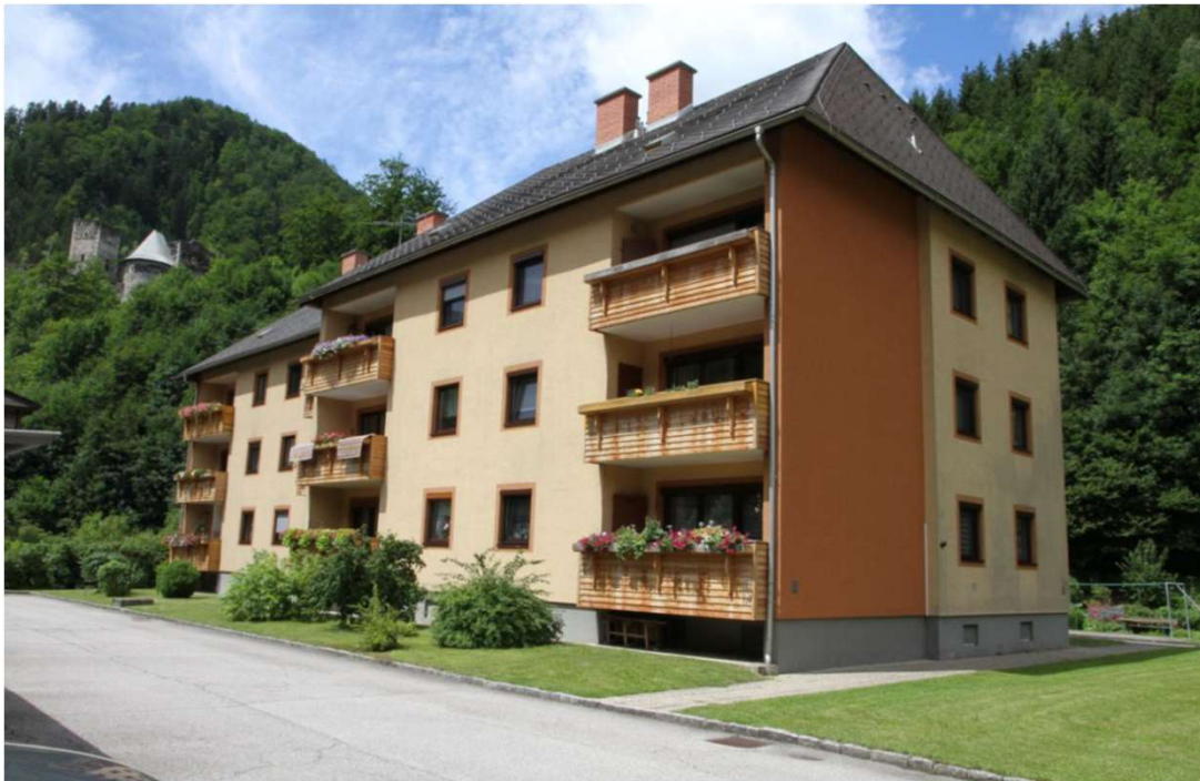
Bsp. für Umstieg auf Pelletkessel in Thörl. Wohnanlage mit 12 WE, © Siedlungsgenossenschaften Ennstal
