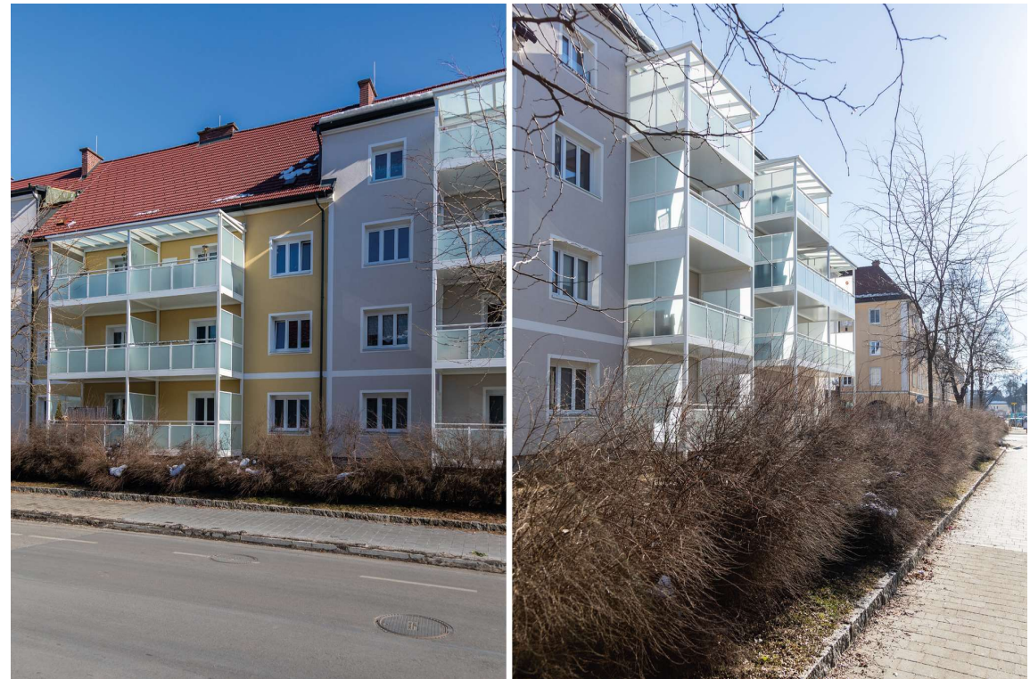
Beispiel einer Klagenfurter Wohnanlage mit 25 WE, in der ein Umstieg auf eine zentrale Fernwärmeversorgung durchgeführt wurde. Quelle: © LWBK
